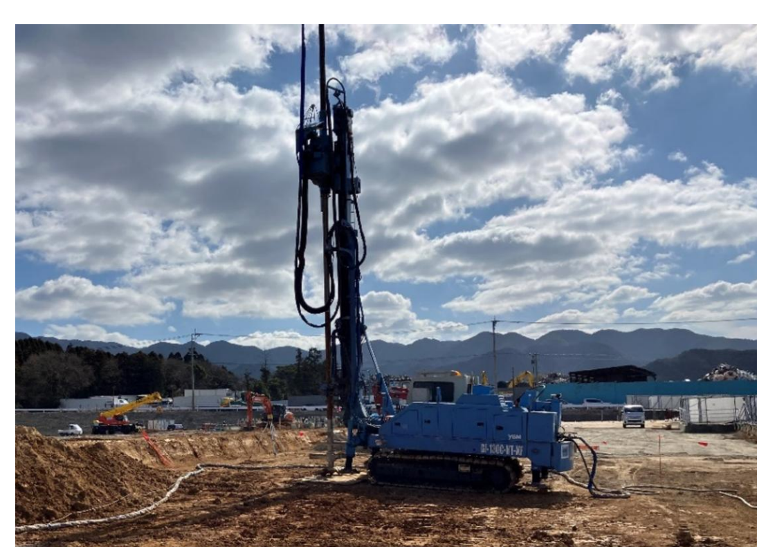
CUCO®-CO 2 固定地盤改良
