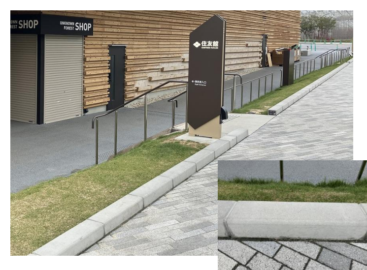
人工石灰石を使用したコンクリートブロック（大阪・関西万博/住友館で境界ブロック、側溝として供用）
