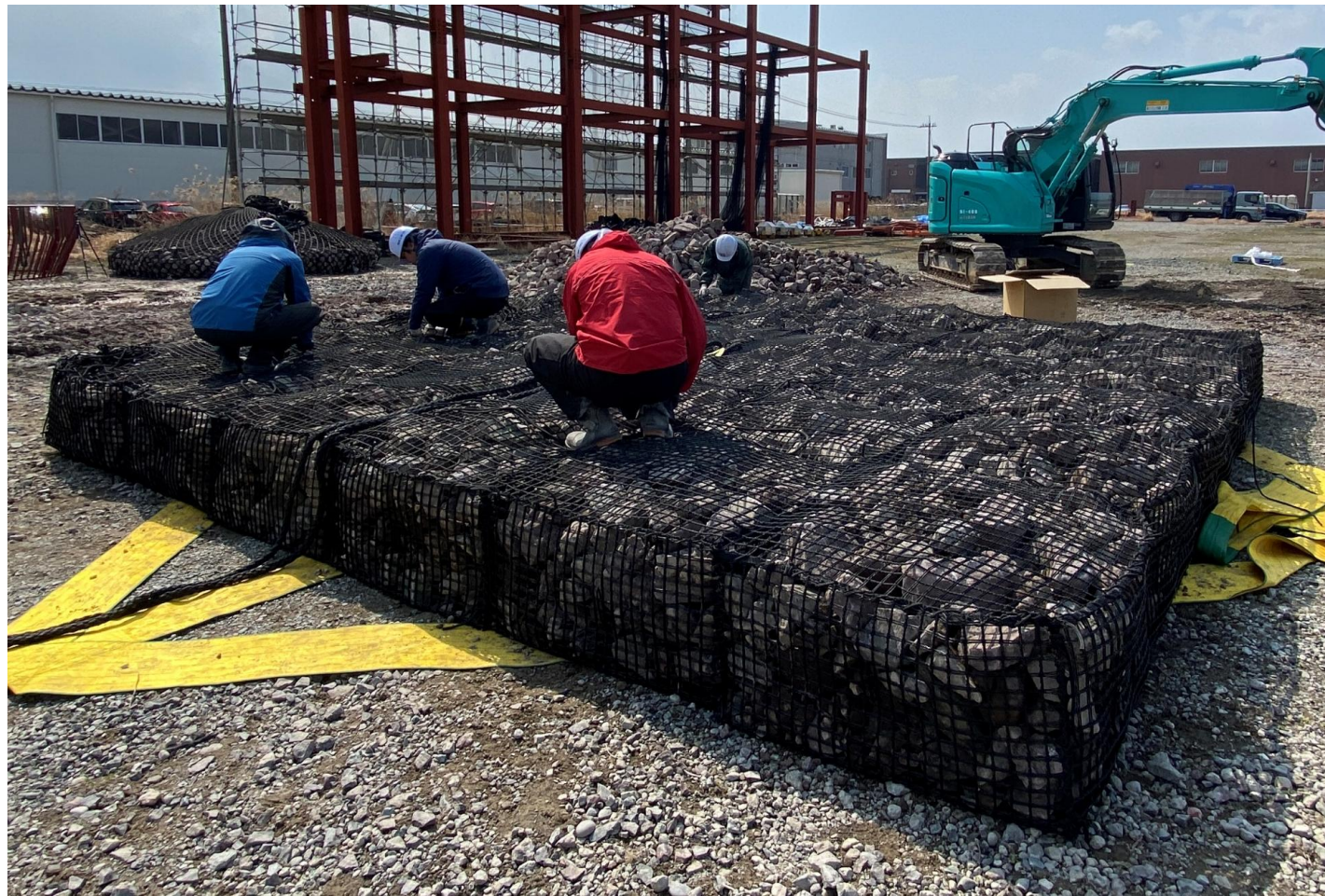
矩形袋型根固材 （B6m×L6m×H0.5m）
