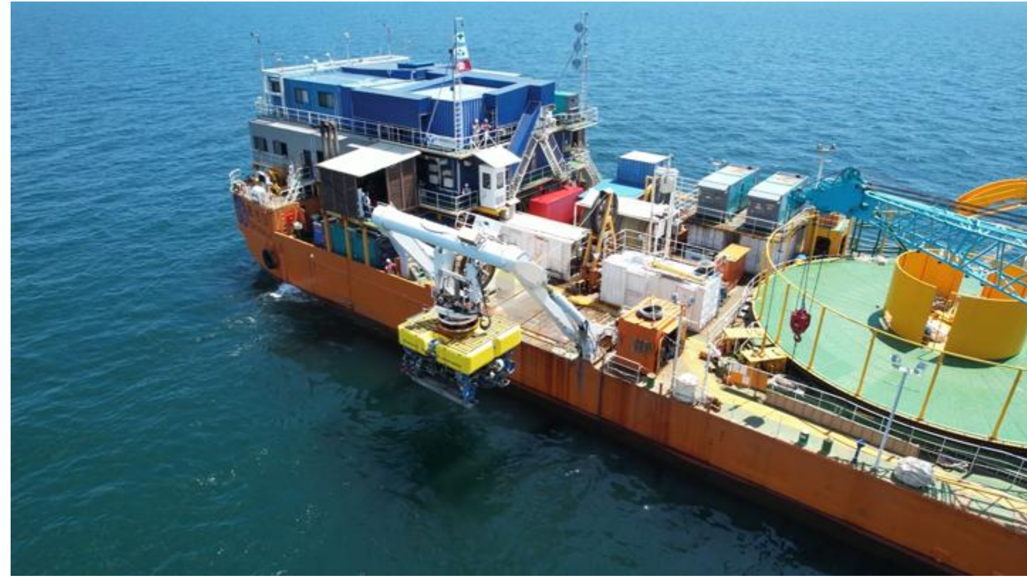
実海域実験状況 (ケーブル埋設機投入状況)
