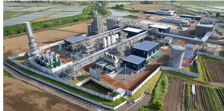
実証プラント建設状況（2026年5月26日撮影）
