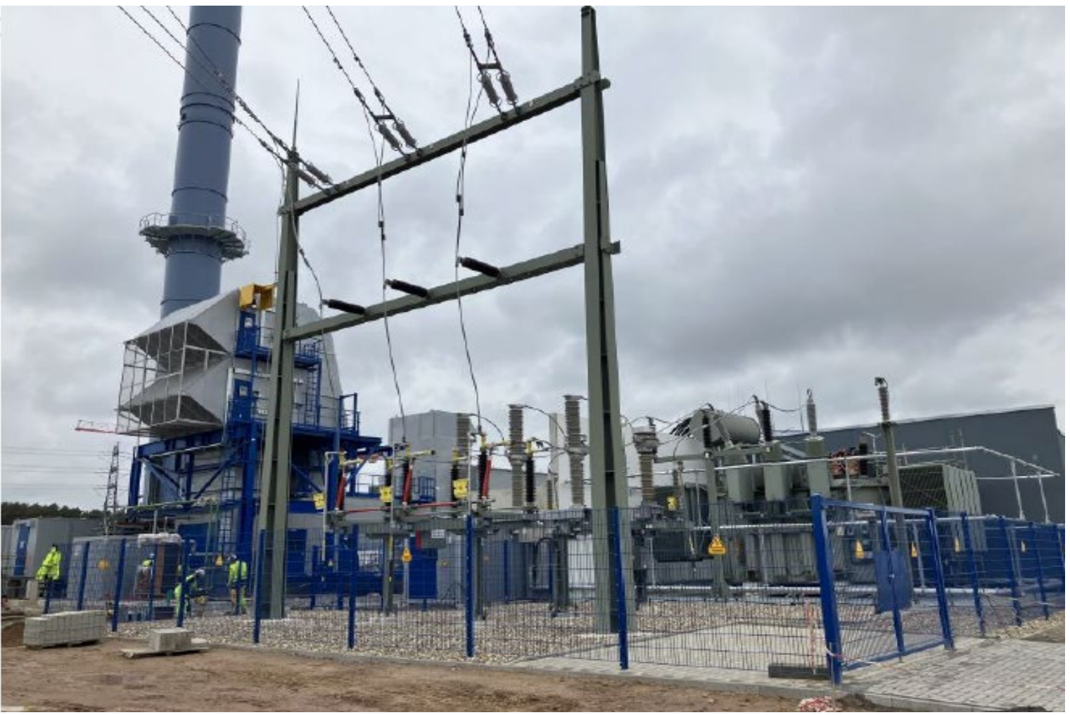
ガスタービン発電装置工事状況（Lingen @ドイツ）
