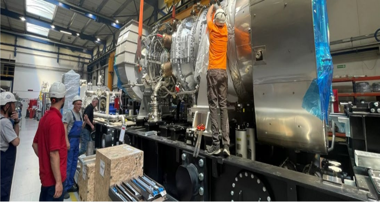
水素ガスタービン発電装置 組立状況
