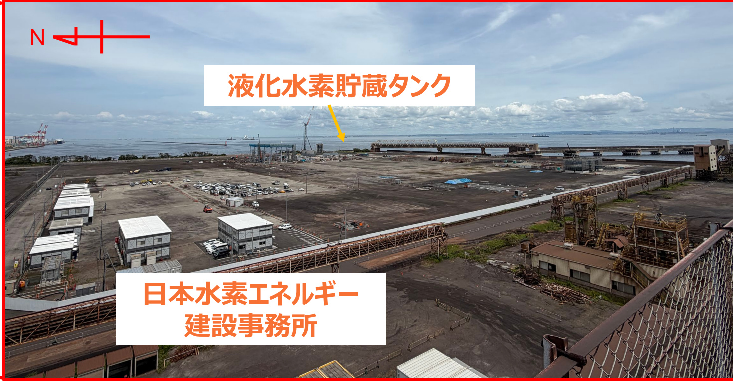
図② 国内基地の建設状況（2026/5/26）
