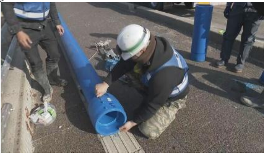
水道配水用PE管施工の様子
