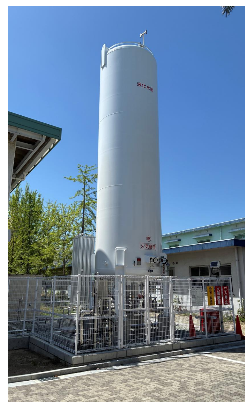
図5 光学クライオスタット 液体水素供給設備 (神戸大)
