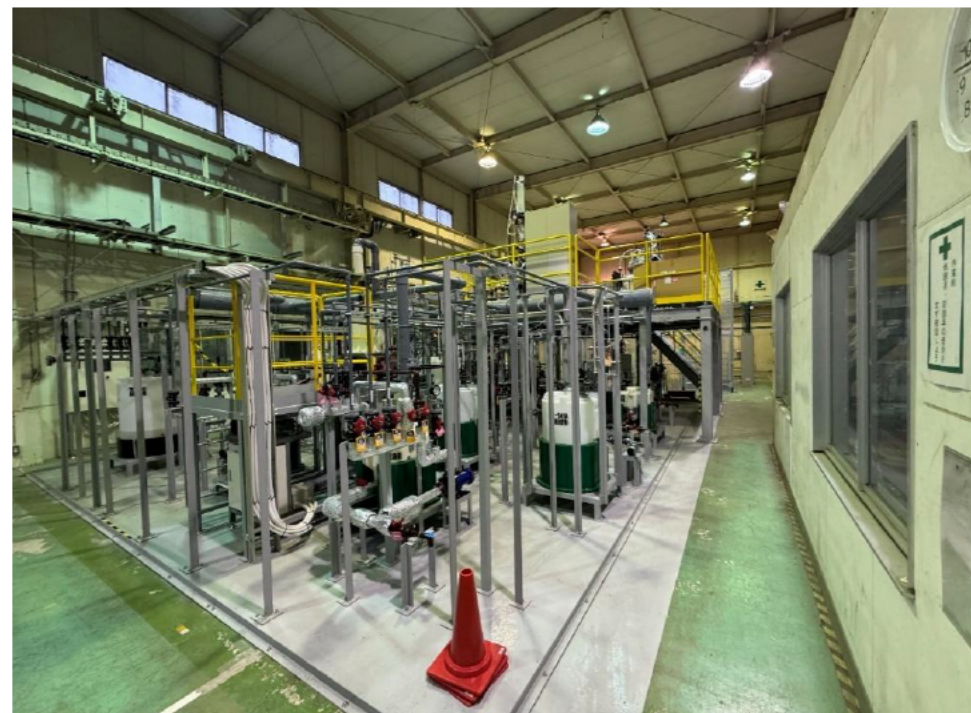
炭素分離・水素製造エリア
