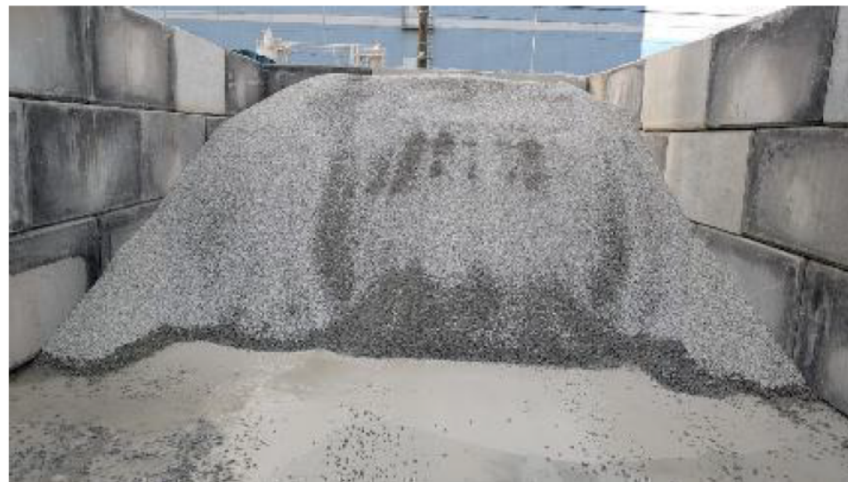
CP骨材(1505)保管(ストックヤード)
