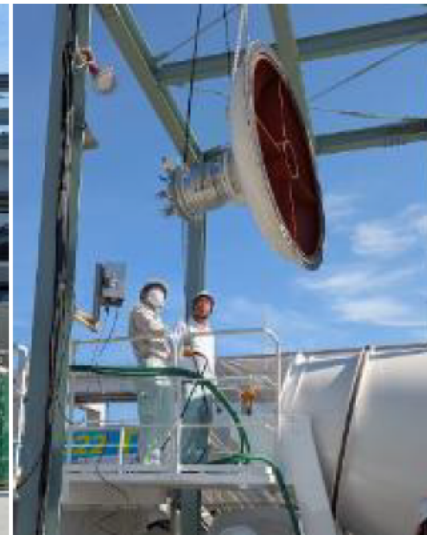
密閉蓋取付作業
