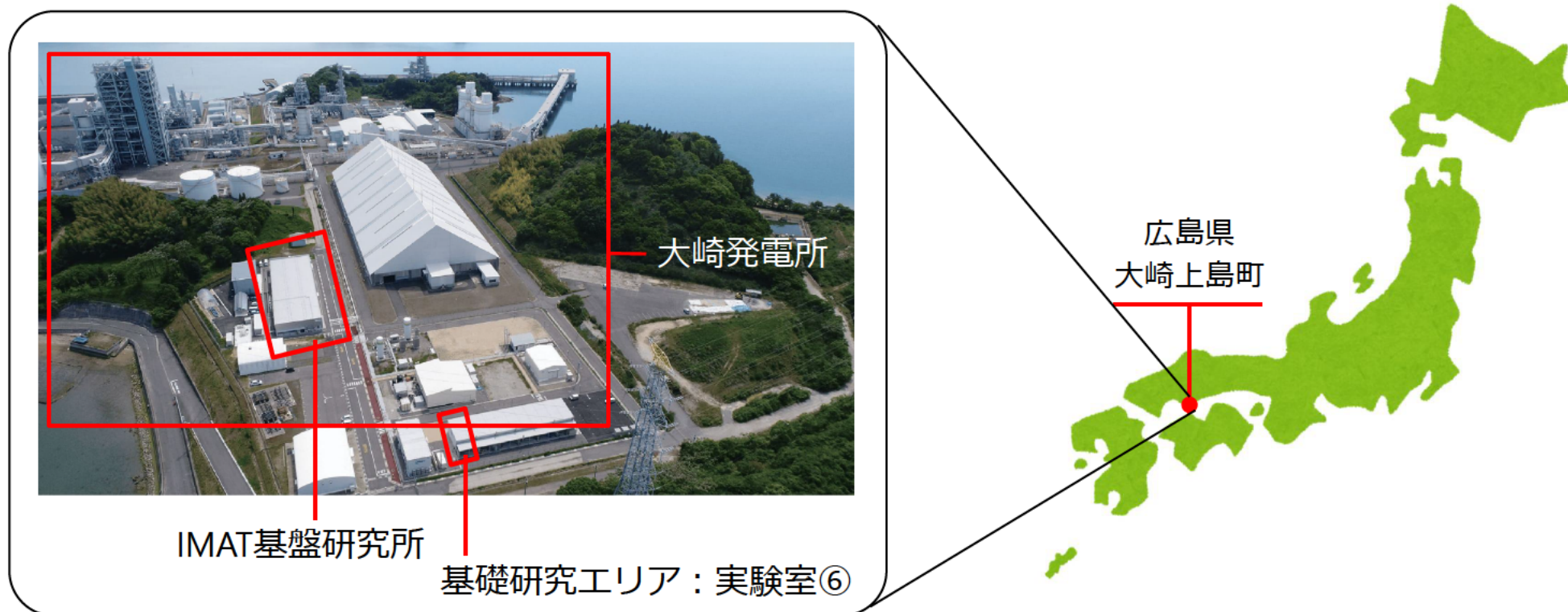
図 カーボンリサイクル実証研究拠点（空撮写真）
