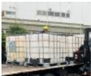
消化液タンク (1000リッター)
