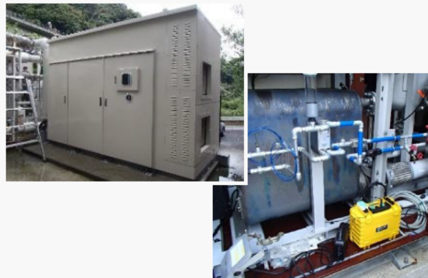
金属腐食対策
