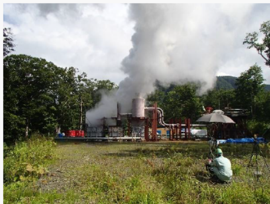
坑井掘削・噴気試験
