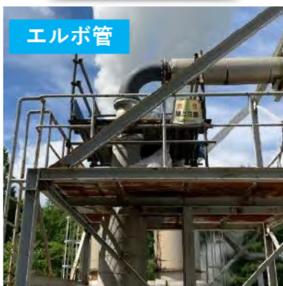
生産井蒸気配管の暴露試験を実施
