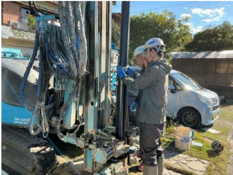
還元井掘削作業 (2025/10/23撮影)
