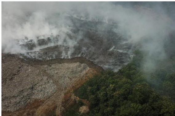
埋立ガスの火災
