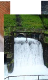
↑余水路(煉瓦積)と 高速射流
