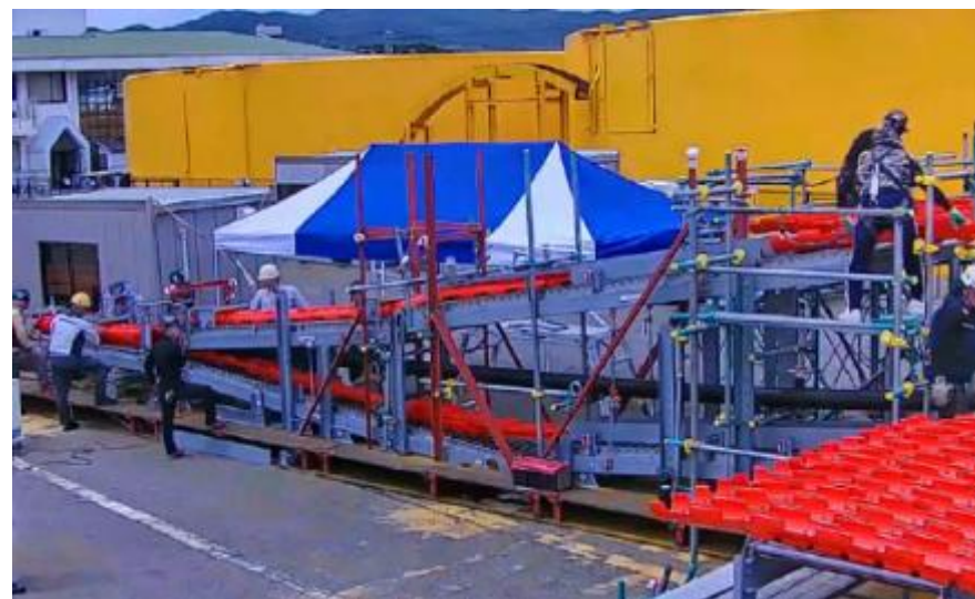
防護管高速取付実機検証
