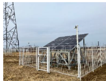
(2)架台下部をIV線で接続
