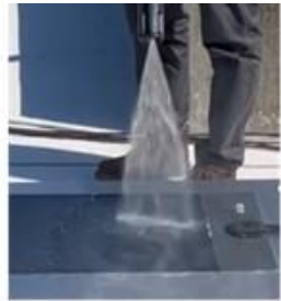
高圧洗浄(高さ30cm)
