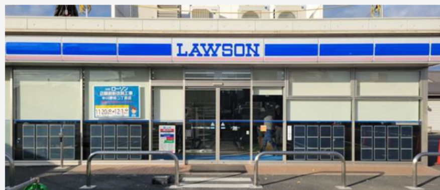
店舗窓枠内側への取付け
