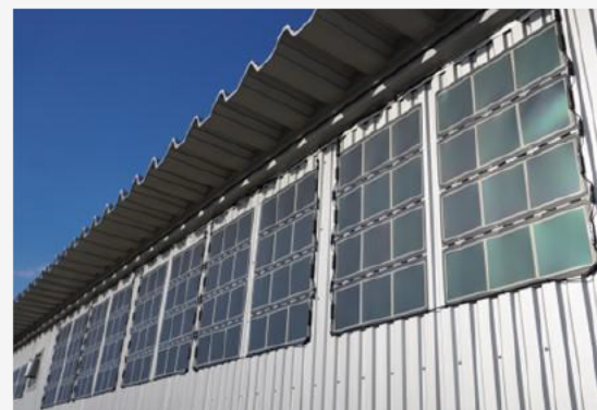
壁面への設置(南西面)
