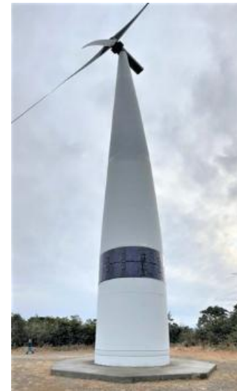
設置完了したペロブスカイト太陽電池
