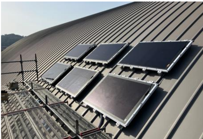
アーチ型屋根への設置
