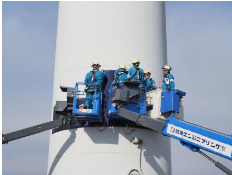
風力発電タワーへの設置状況
