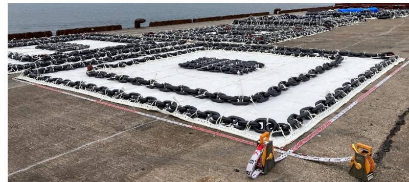
実海域実験で使用した洗掘防止シート (6m×6m)
