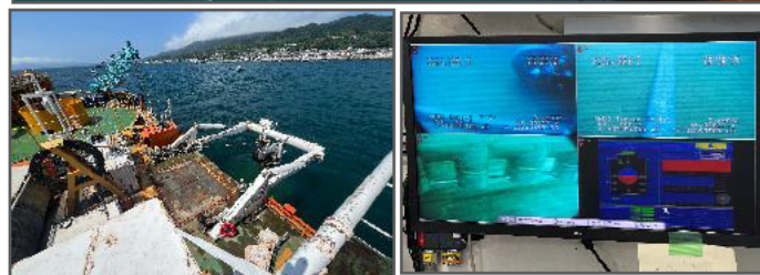
ケーブル埋設
