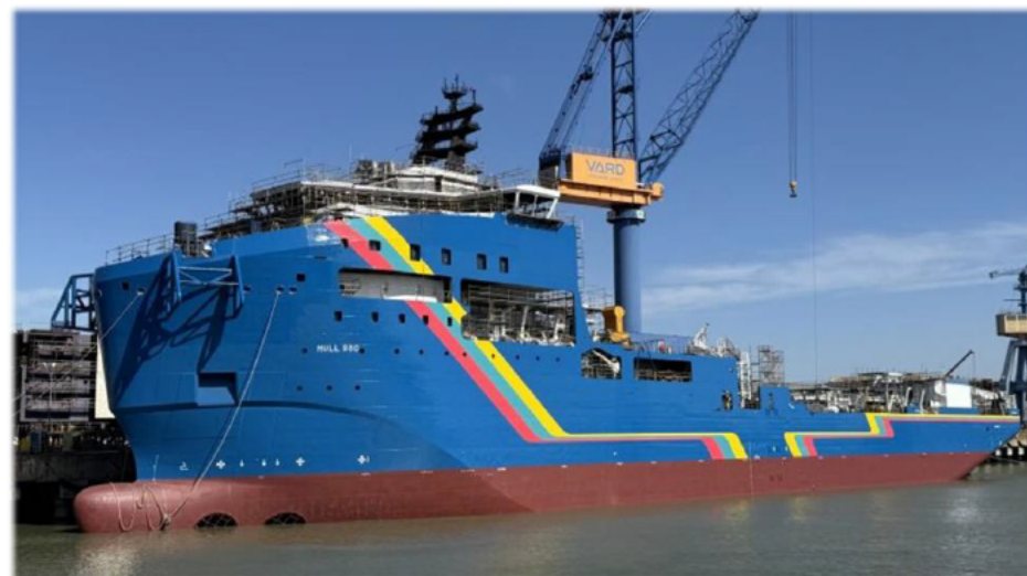
ケーブル敷設船の建造(進水後)
