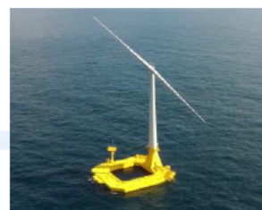
写真8 北九州に設置された 浮体式風力発電（バージ型）
