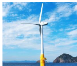
写真6 五島沖浮体式 （スパー型）
