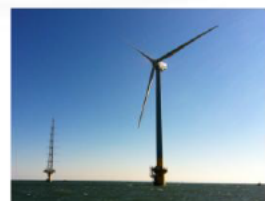
写真4: 洋上風力発電実証 (左) 銚子沖、(右) 北九州市沖
