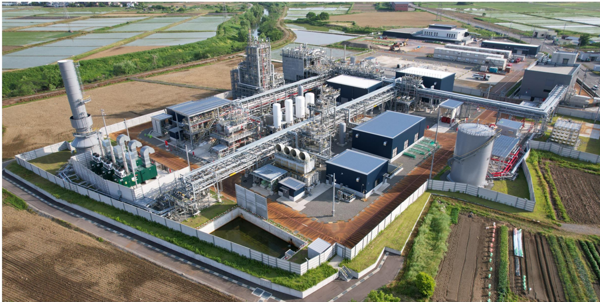
実証プラント建設状況(2026年5月26日撮影)
