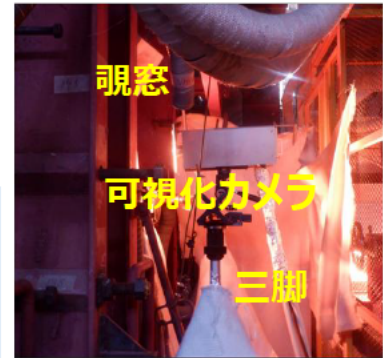
Fig. 可視化カメラでの撮影の様子
