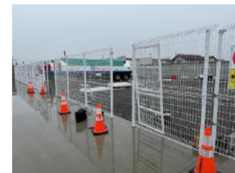
フェンス工事
