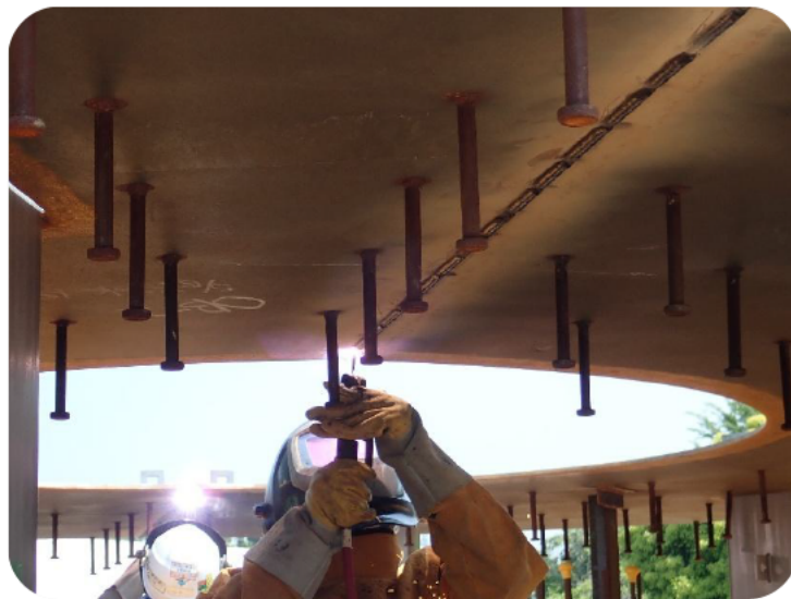
外槽底部ライナの溶接
