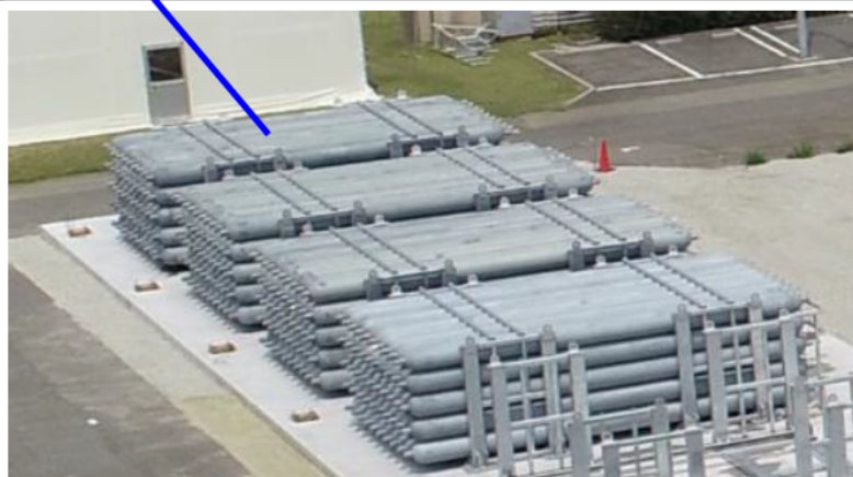
(参考)既設350本：全7基中、4基を据付時点
