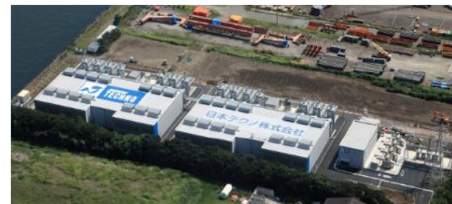
110MW 発電プラント@袖ヶ浦
