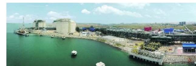
シンガポールLNGプロジェクト
