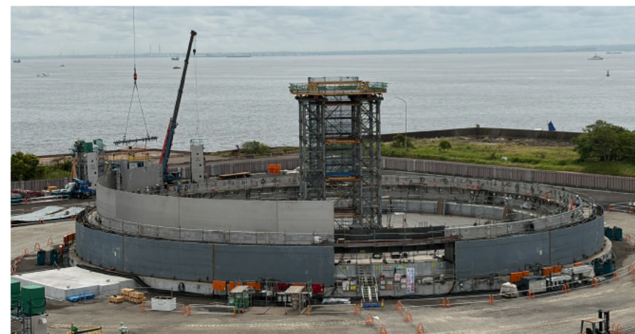
液化水素貯蔵タンク建設状況（'26/5/26撮影）
