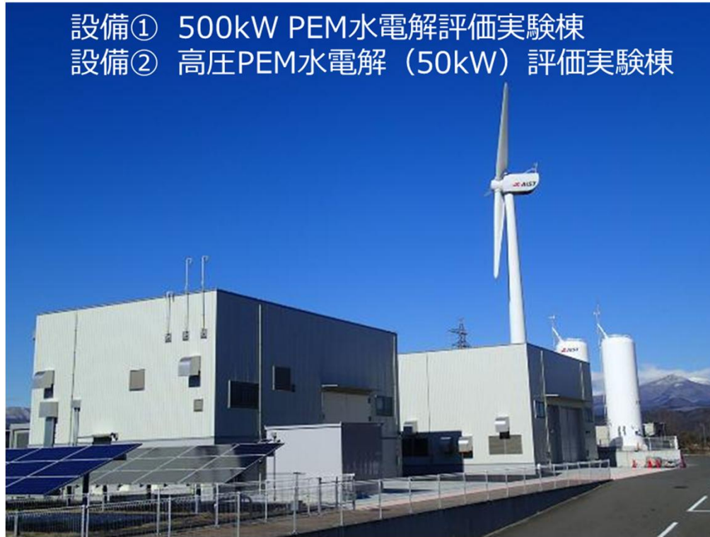
2023年度 専用建屋及び装置設置完了
