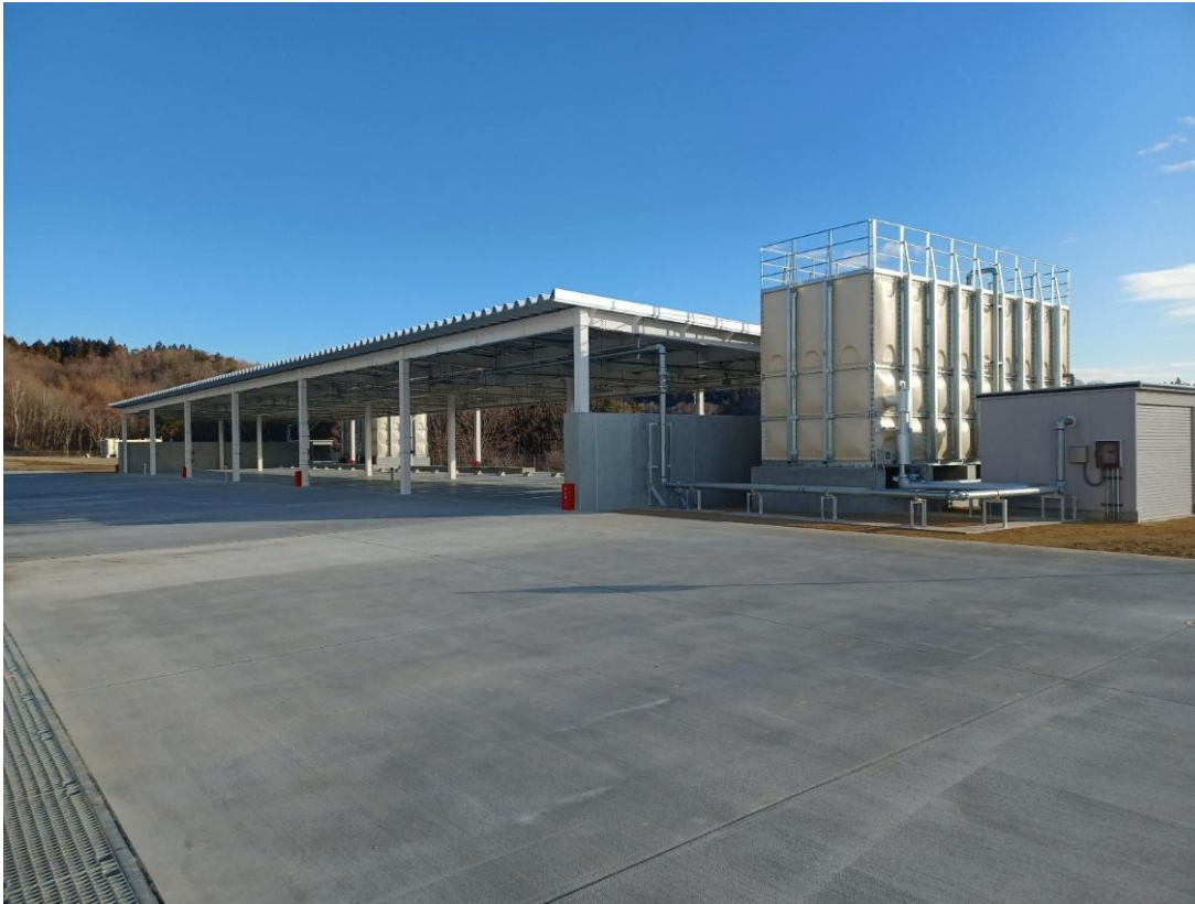
水素ガストレーラー庫
