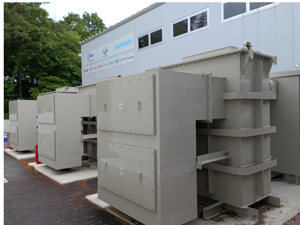
実証サイトへ据付状況
