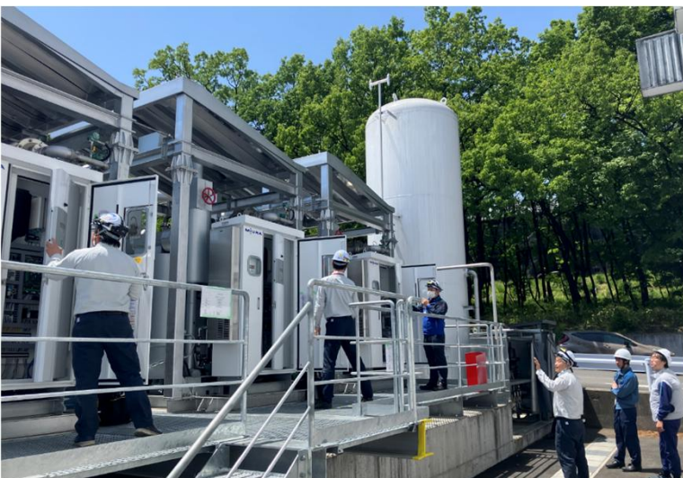
実証先据付後の水素ボイラ 単独試運転完了
