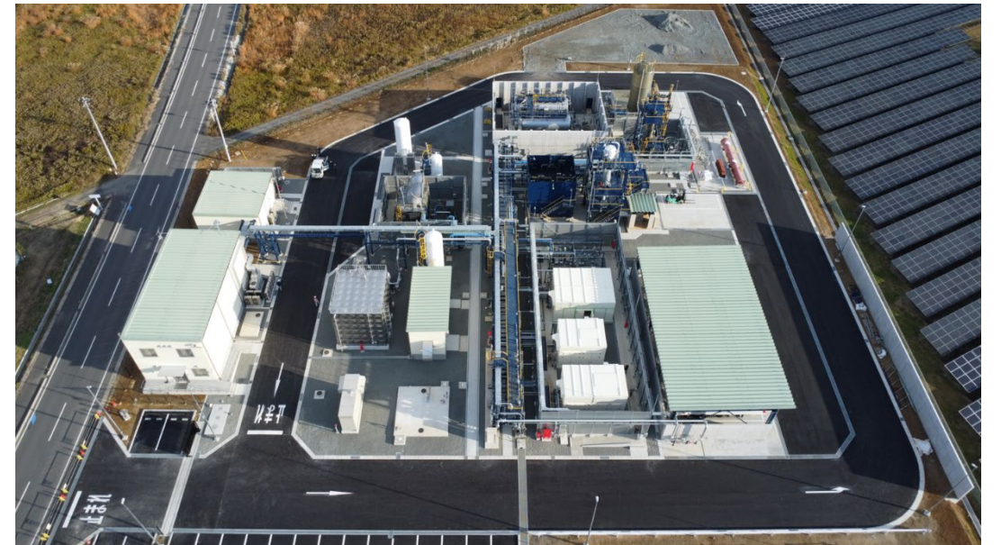
アンモニアプラント俯瞰図（2024年12月）
